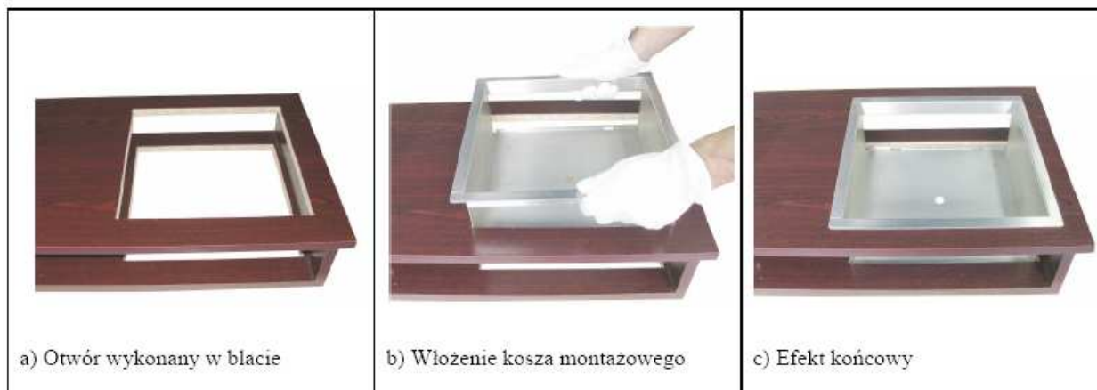
Rys. 3. Przykład zabudowy kosza montażowego
